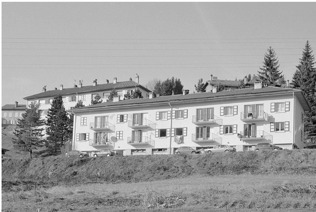
Logement d'ouvriers, depuis le sud-est.
