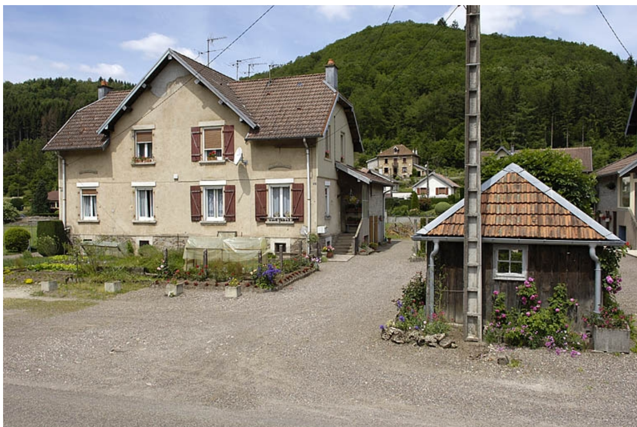
Logement de contremaître.
