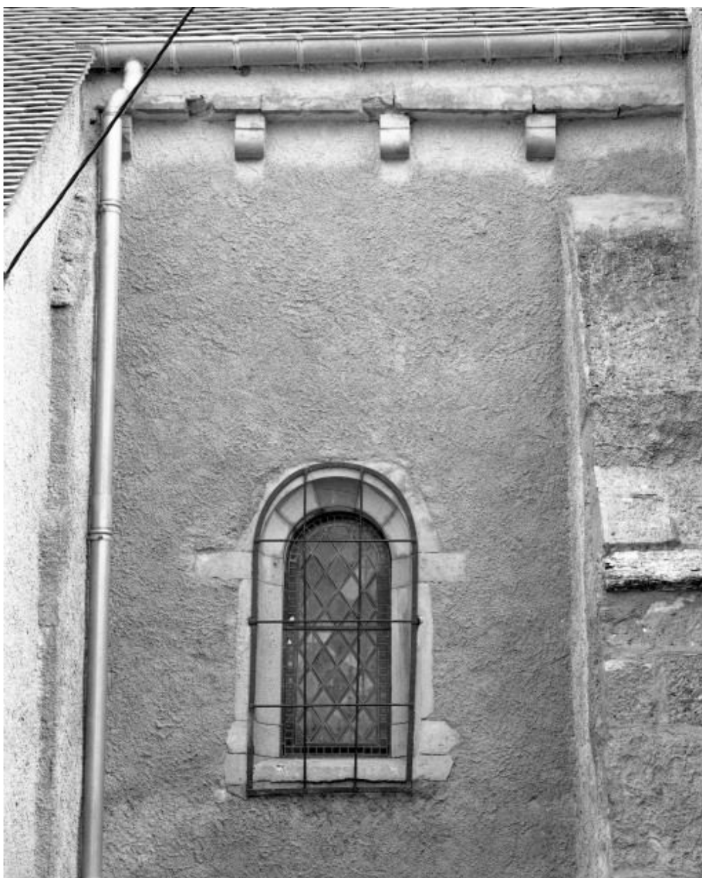
Elévation gauche, fenêtre et corniche du choeur
