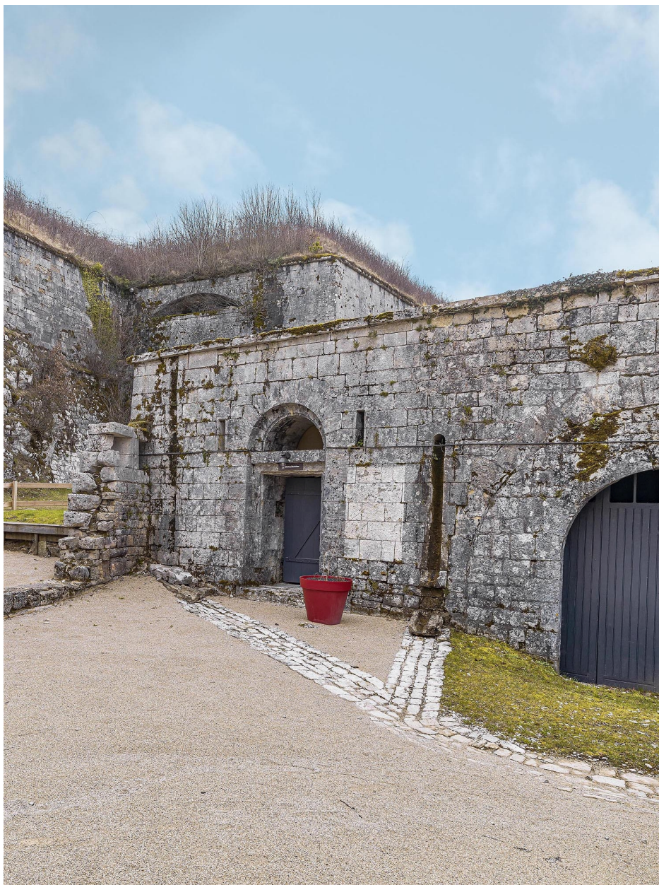
Entrées des casemates du flanc gauche.
