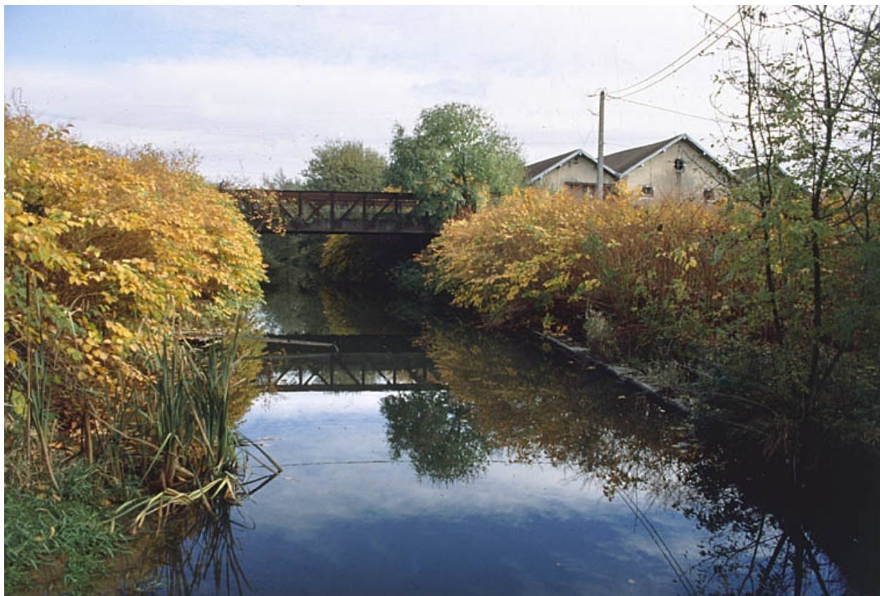
Canal d'amenée depuis l'aval.
