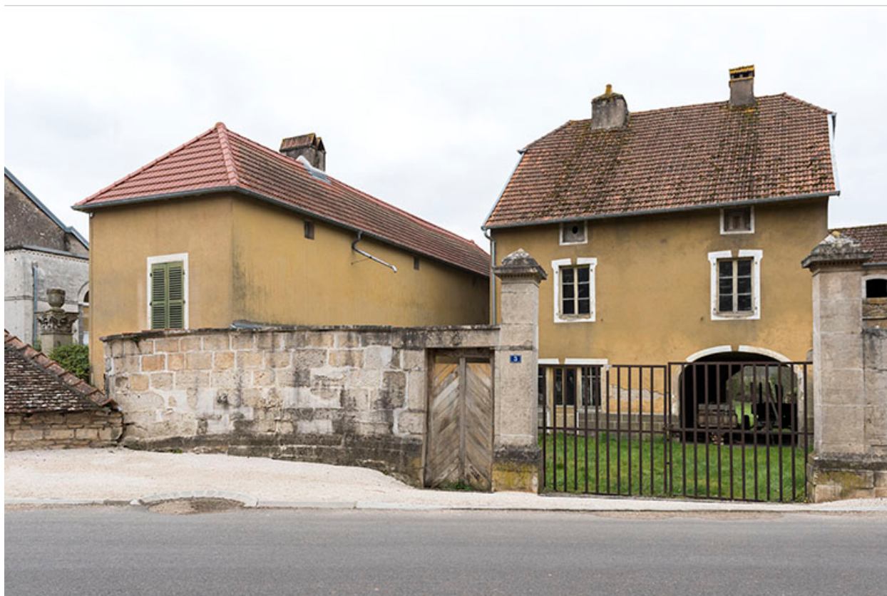
Ferme (?) avec boutique, 3 rue du Pâquis.
