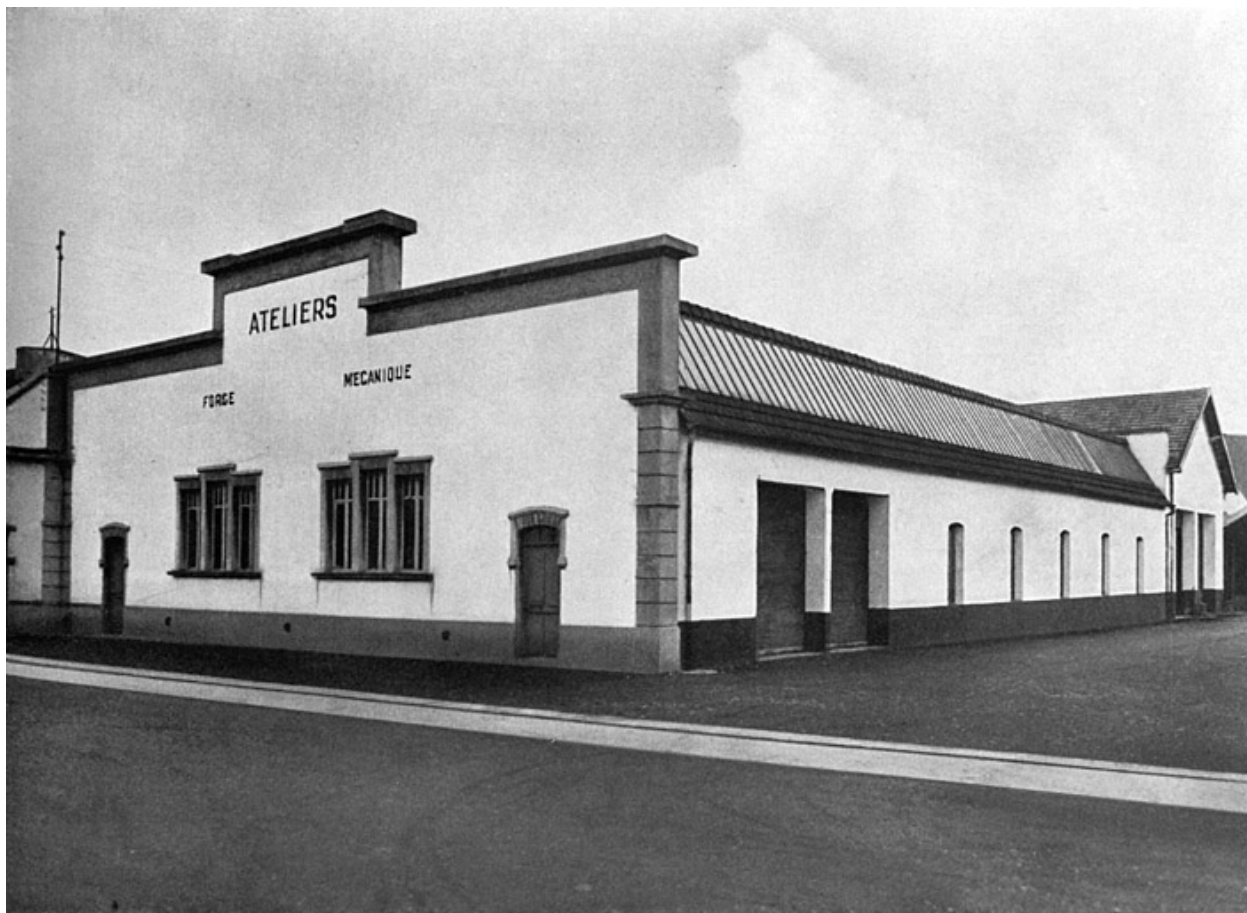
Ateliers de mécanique.
