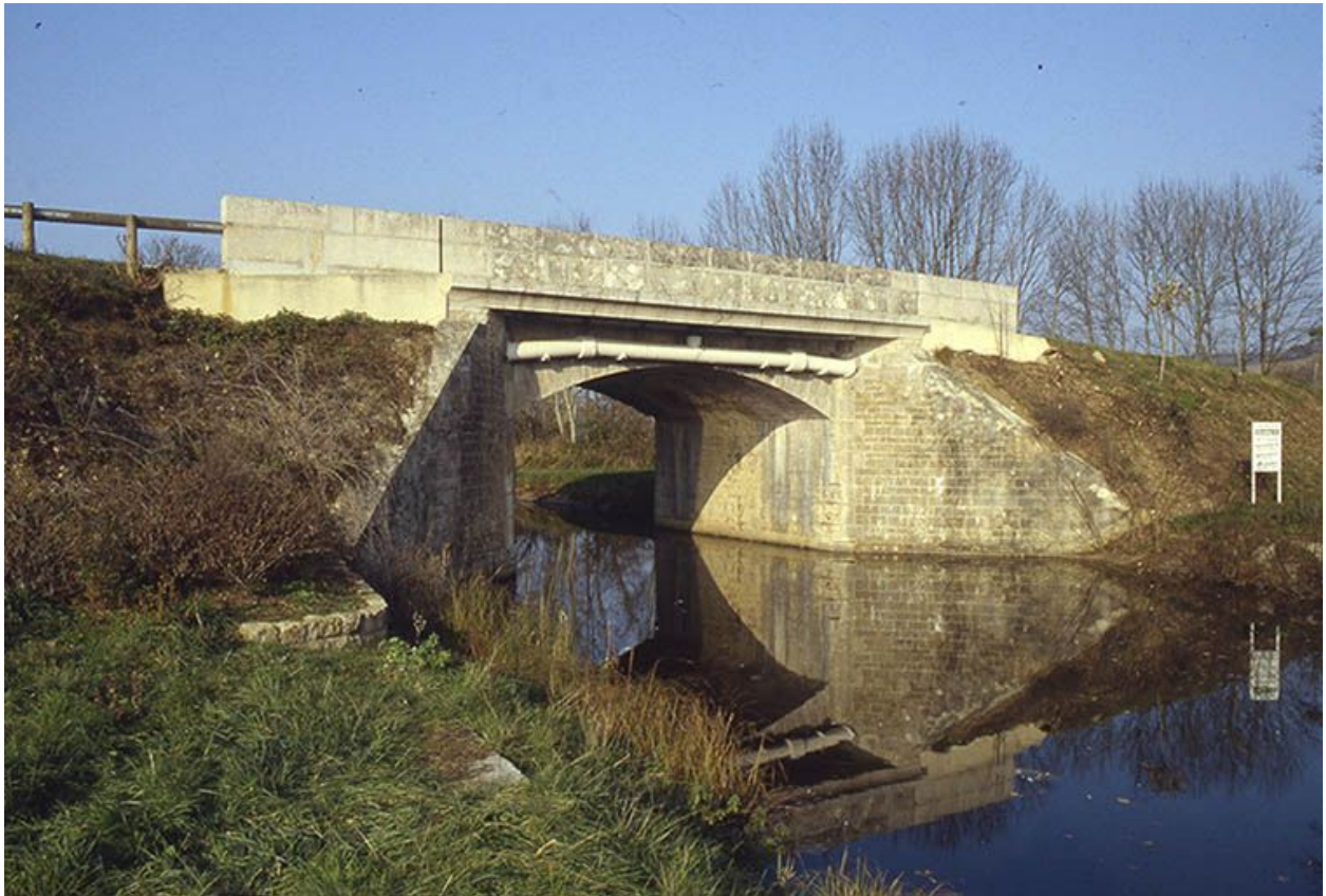
Vue d'ensemble prise de l'aval.
