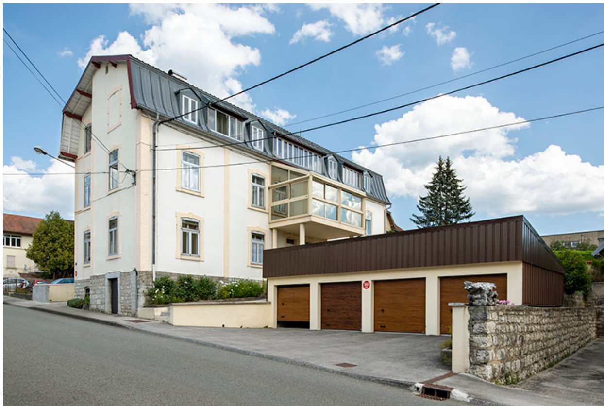
Façades antérieure et latérale gauche.
