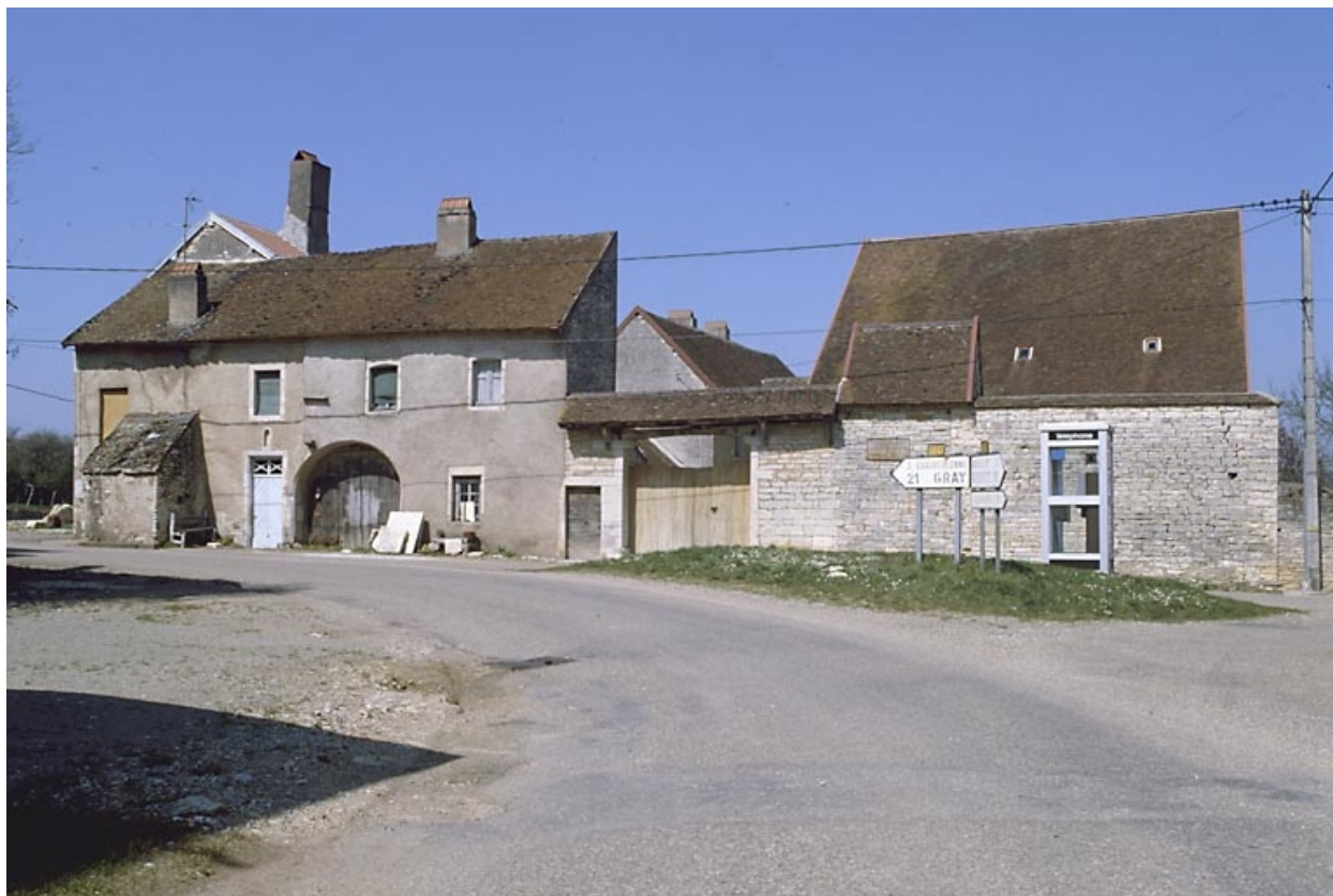
Vue d'ensemble après destruction du bâtiment agricole.
