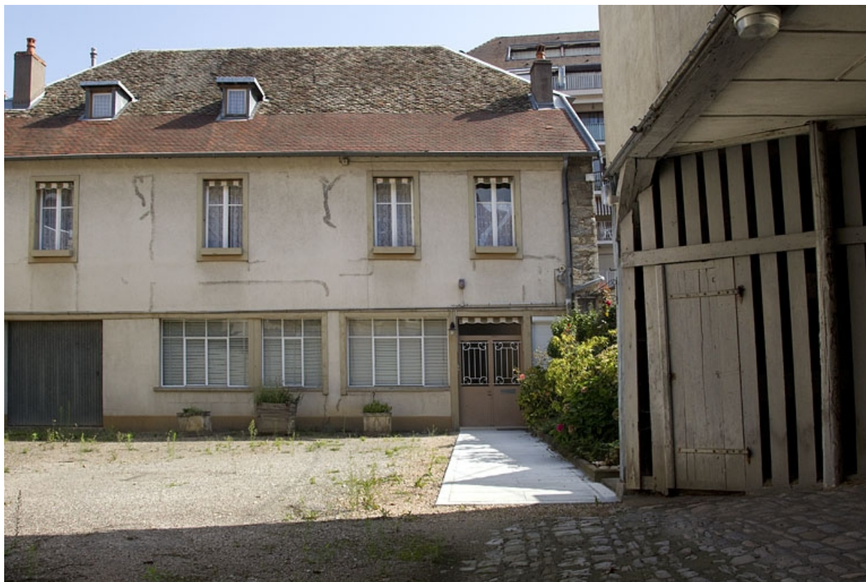
Deuxième logis secondaire : vue d'ensemble.
