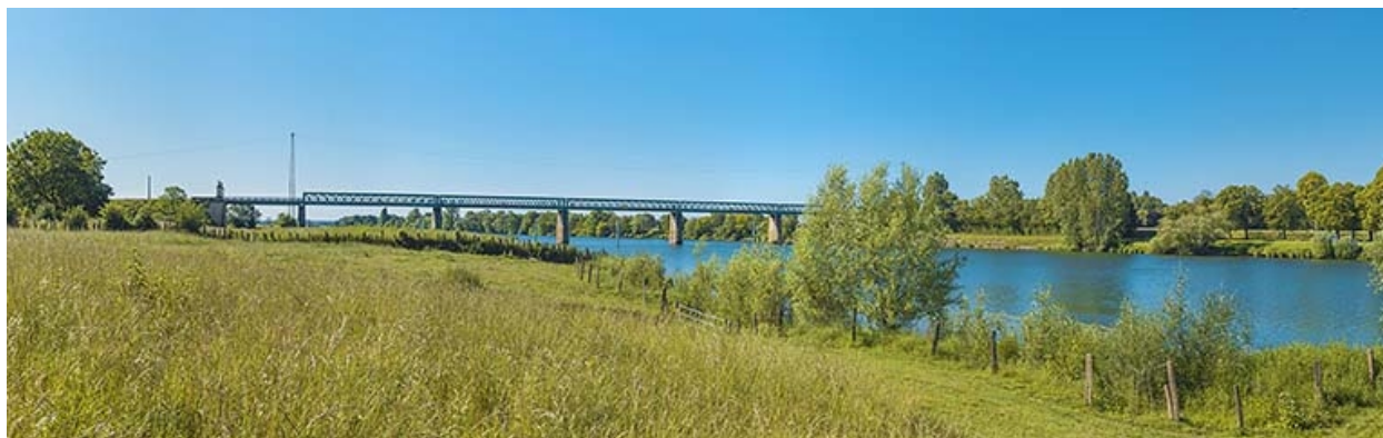
Vue d'ensemble d'amont.
