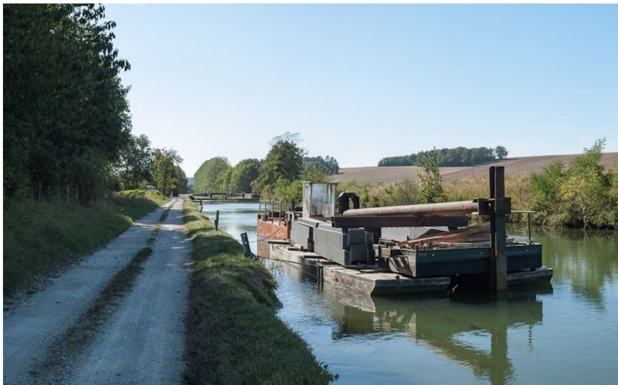
Barge de travaux sur palplanches à Ancy-le-Franc.
