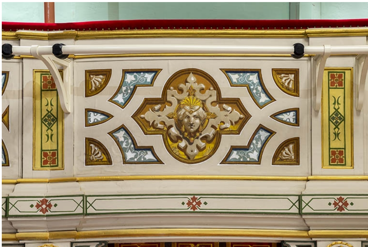
Salle : décor du garde-corps du 2e balcon.
