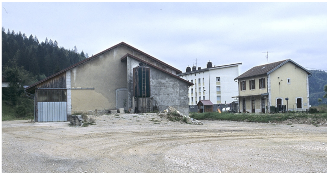
Entrepôt, depuis le nord (côté Andelot-en-Montagne).
