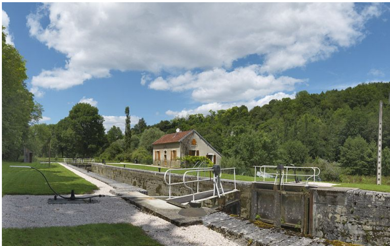
Vue d'aval du site d'écluse 17.
