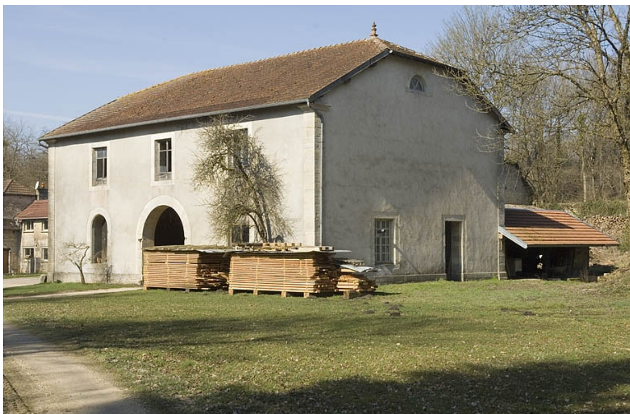
Bâtiment du haut fourneau depuis le sud-est.
