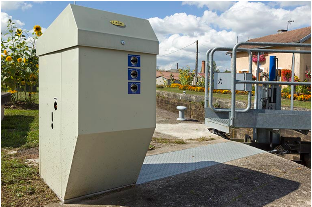
Boitier de commande de l'écluse sur la rive gauche.
