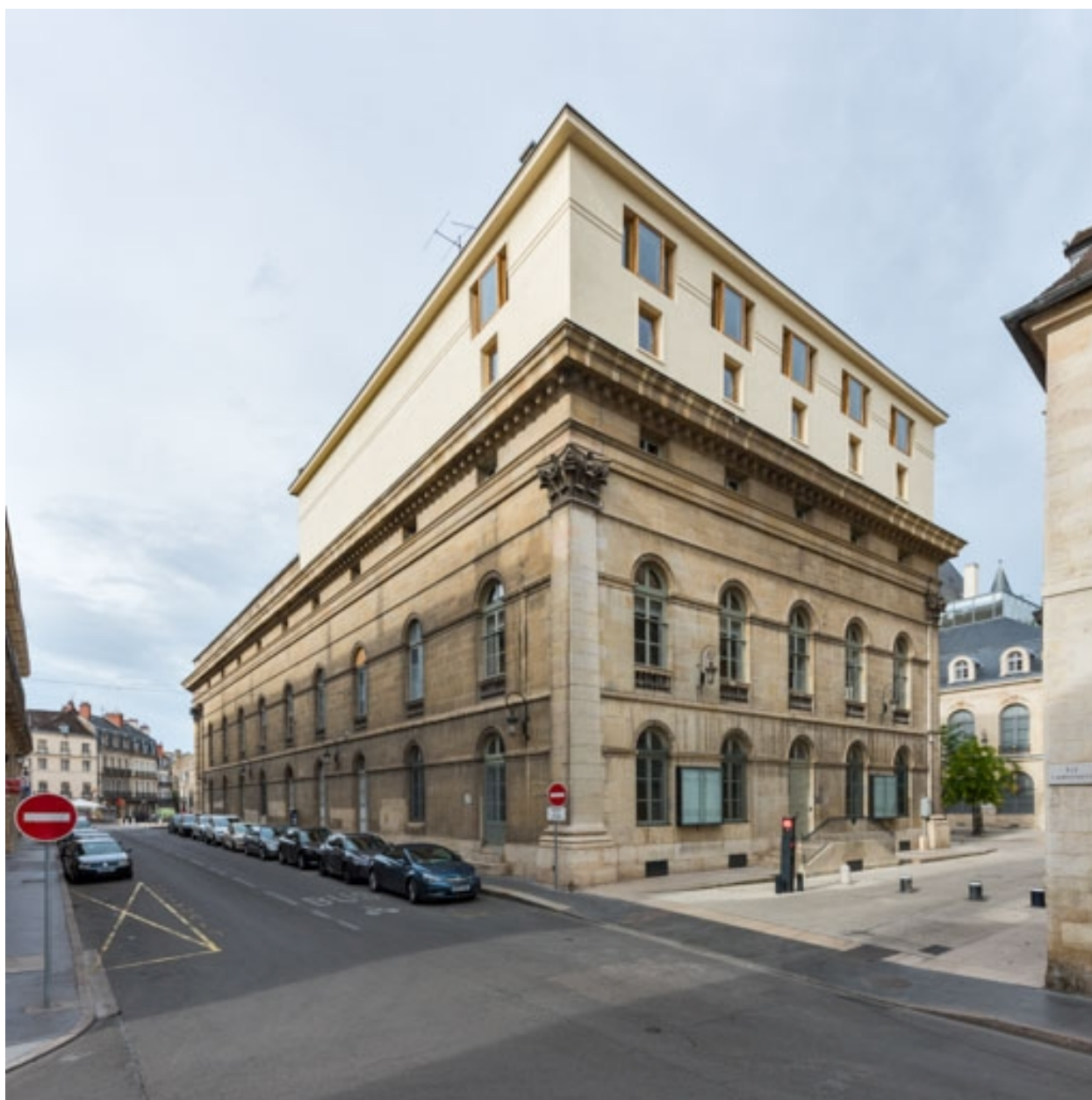
Façades postérieure et latérale droite.
