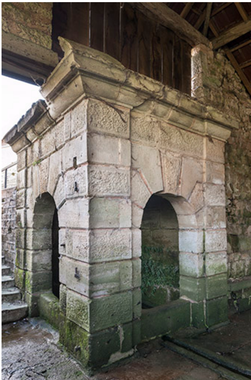
La fontaine alimentant le lavoir.
