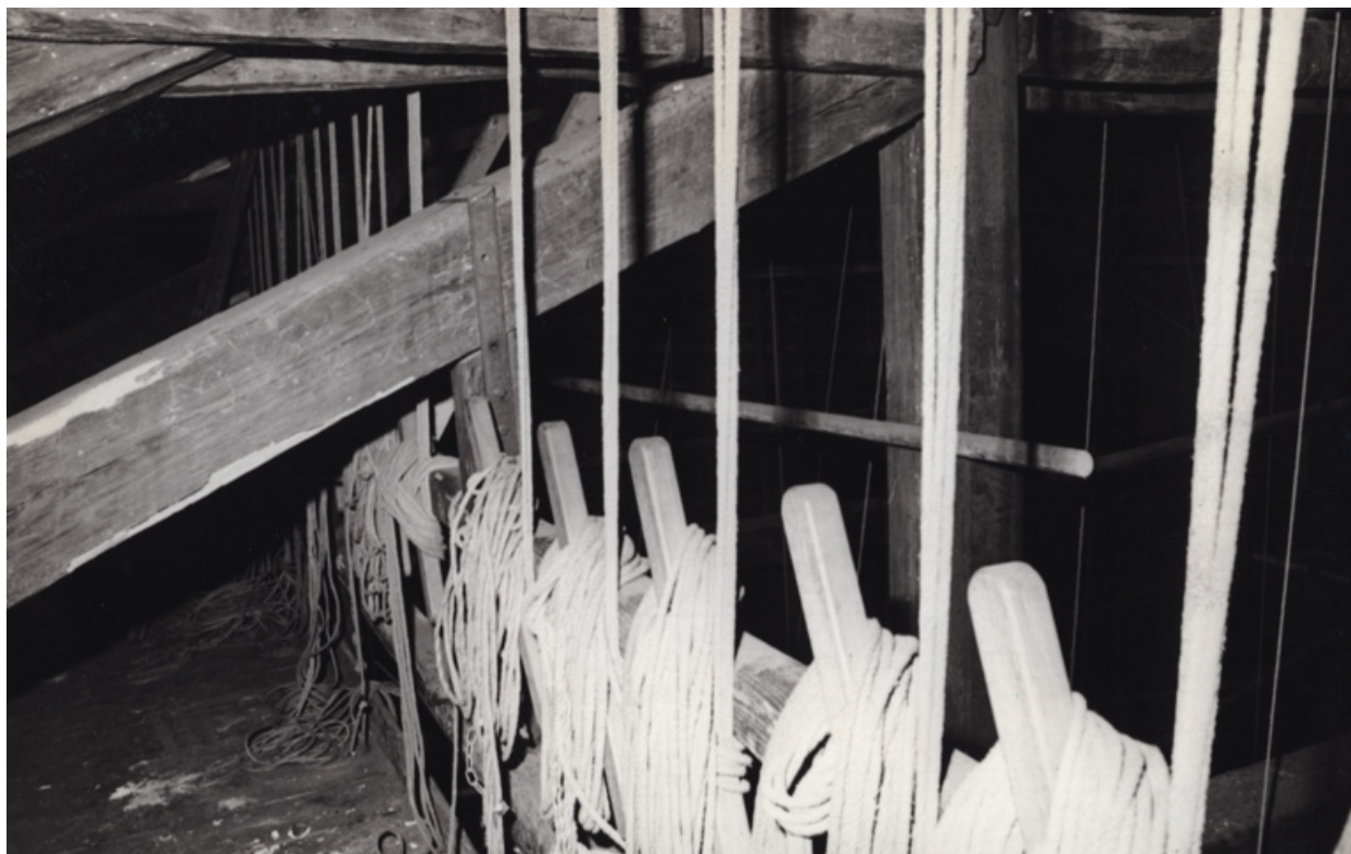
Théâtre, comble, machinerie [palettes de fixation des fils, dans le comble]. 2 février 1977. (Archives municipales, Nevers : 6 Fi 3340).
