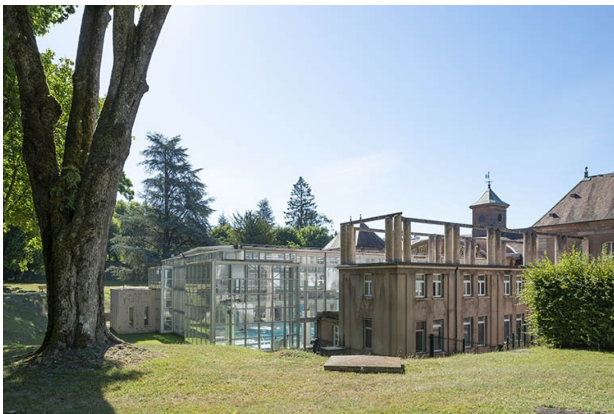
Vue en direction de l'établissement thermal.
