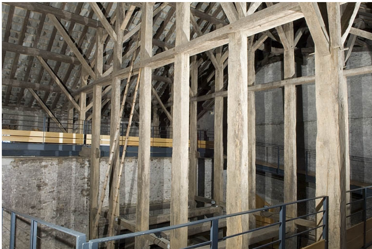
Charpente du fenil (cadrage vertical).
