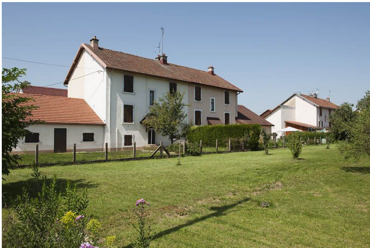
Façade postérieure des habitations.
