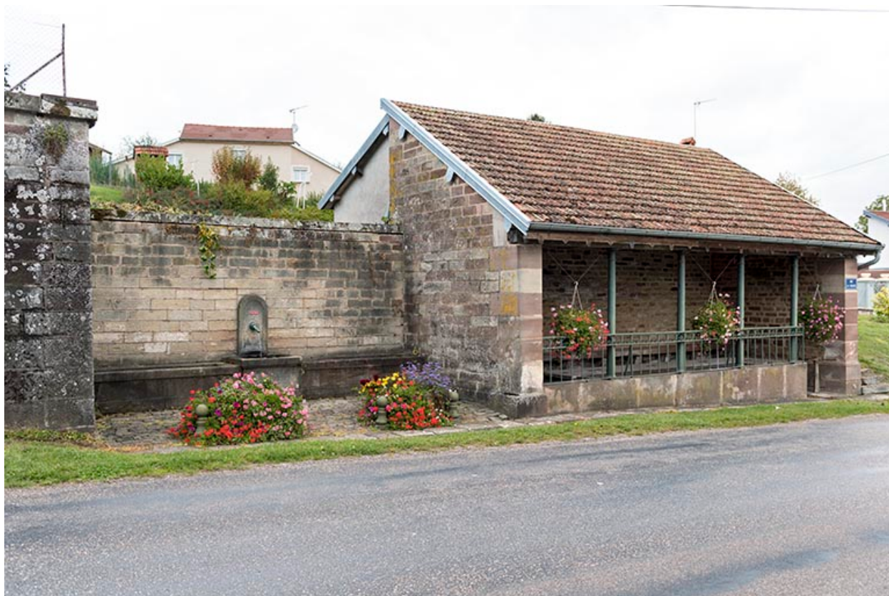
Fontaine-lavoir, rue de la Tuilerie.
