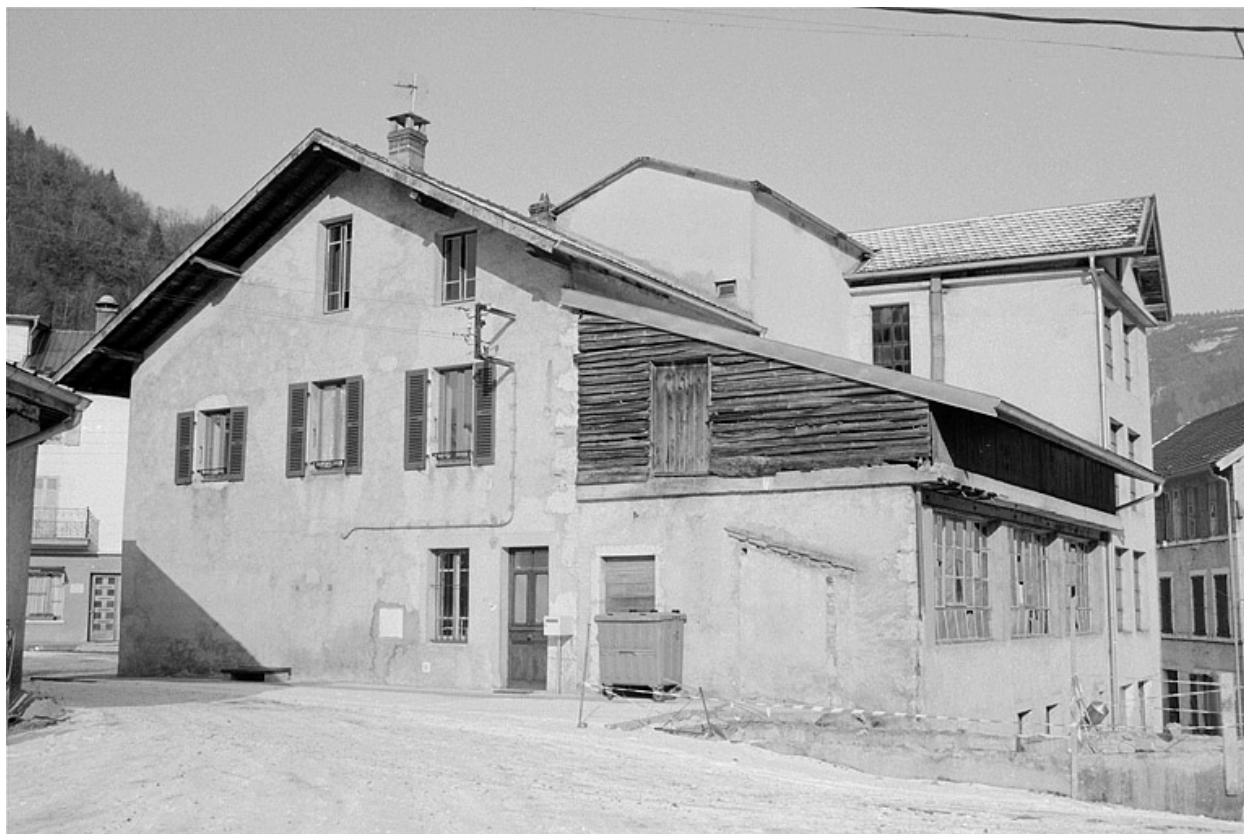
Minoterie, logements et atelier désaffecté.
