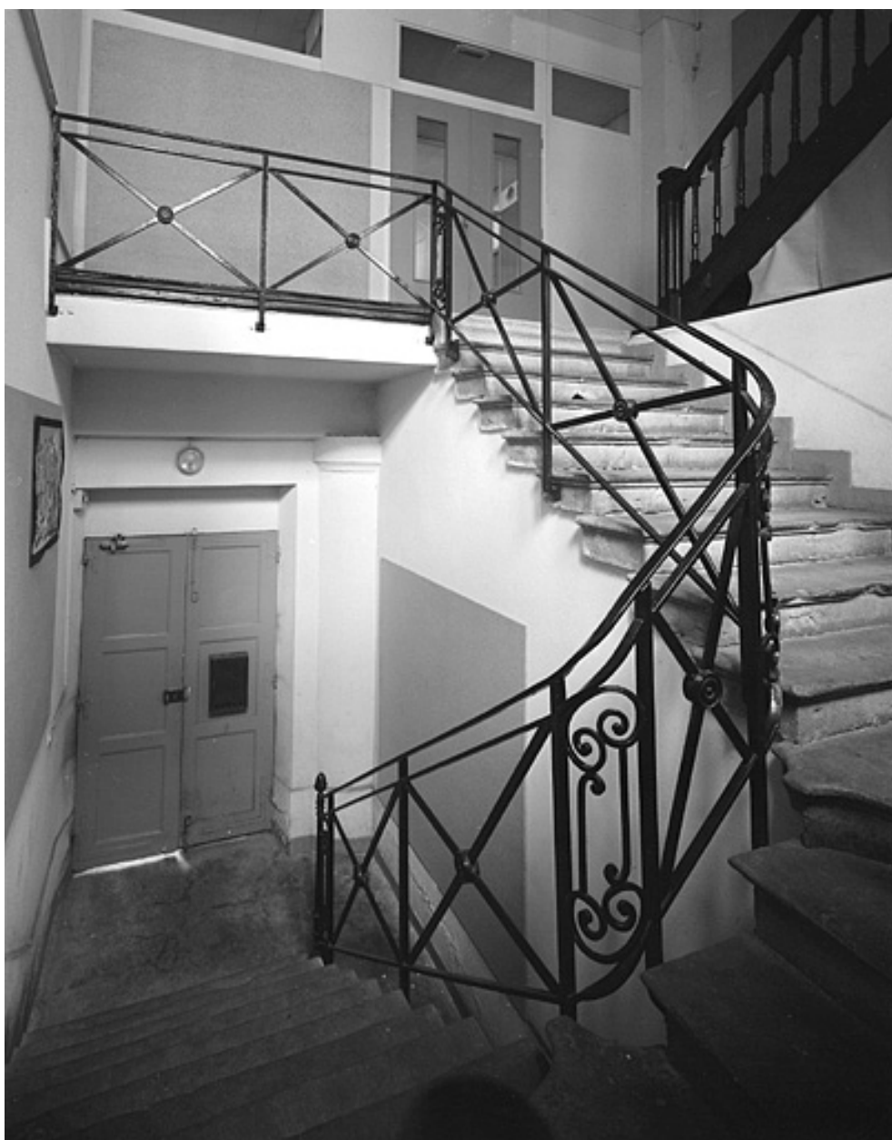
Escalier de l'aile ouest.
