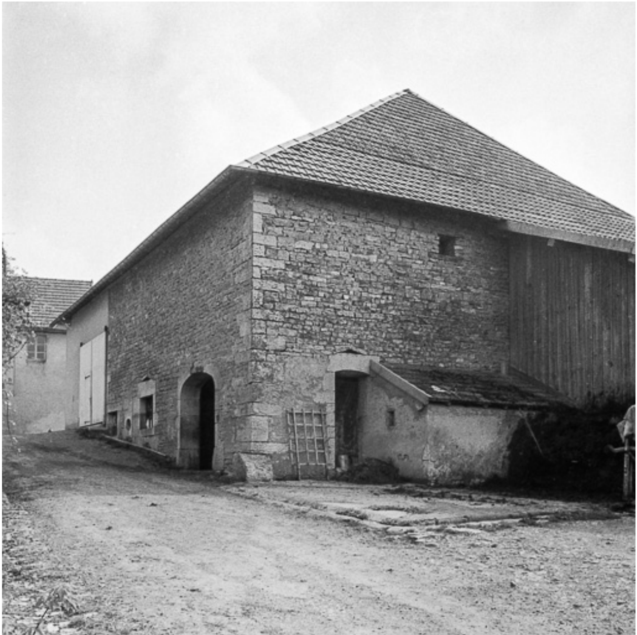
Ferme située rue du Lavoir : façade antérieure. La façade postérieure donne sur la place de l'Eglise.
