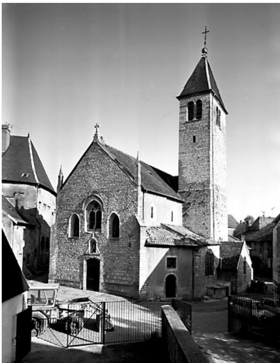
Vue des façades ouest et sud.
