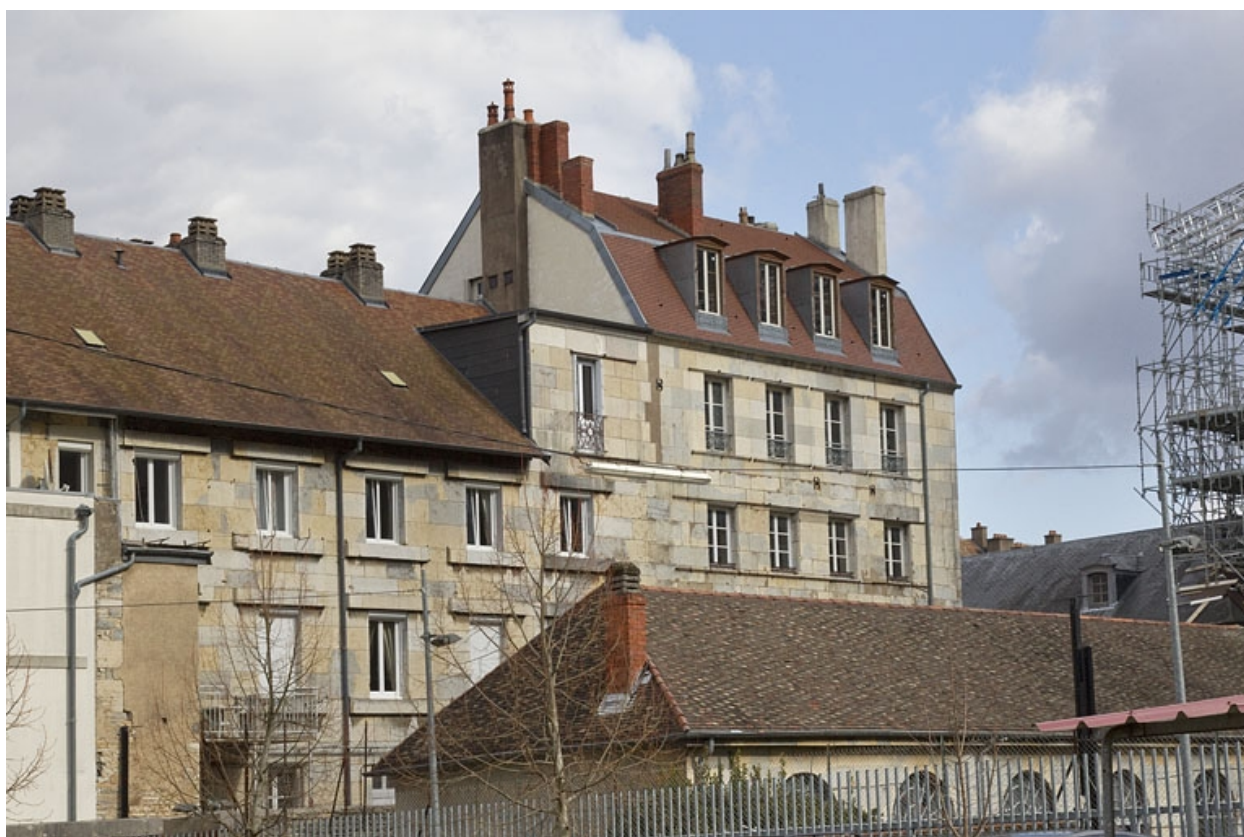
Vue éloignée de l'arrière de l'édifice.
