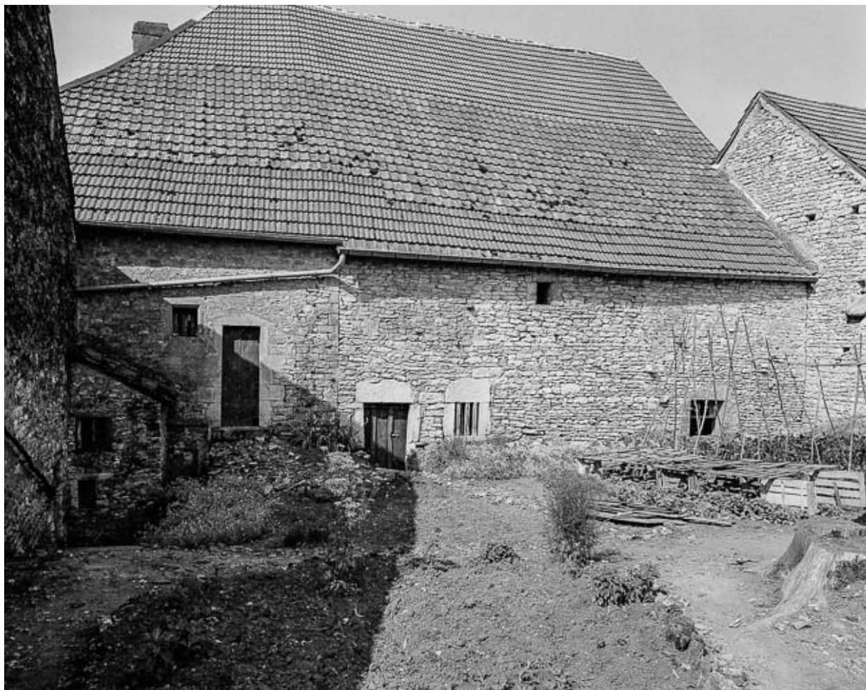
Façades postérieures (détail).
