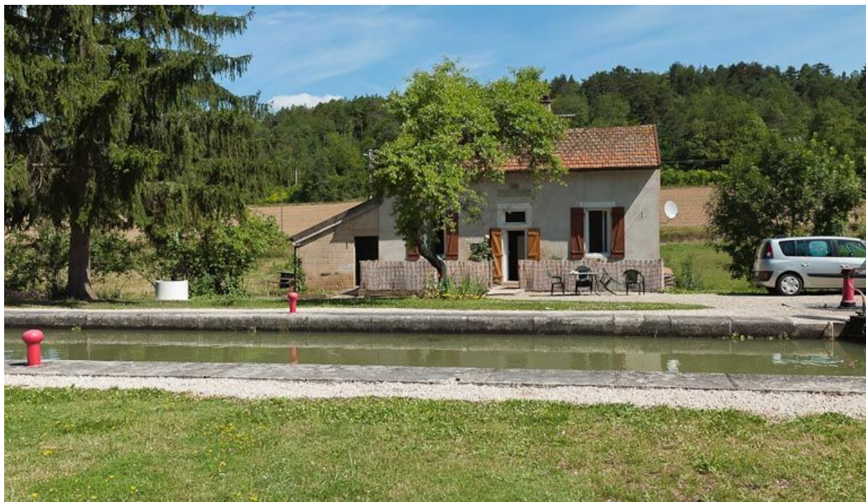
Vue de face de la maison éclusière.
