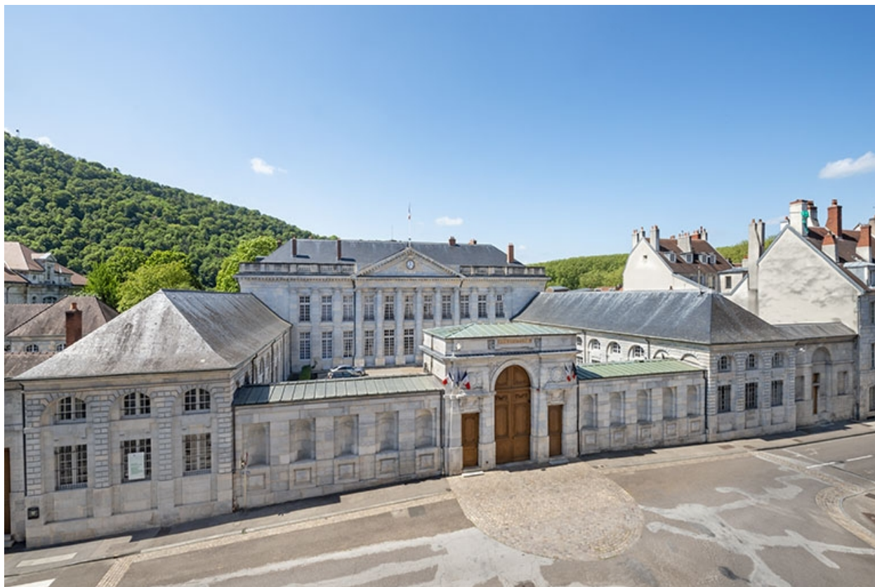
Vue d'ensemble depuis une fenêtre du 9 bis.
