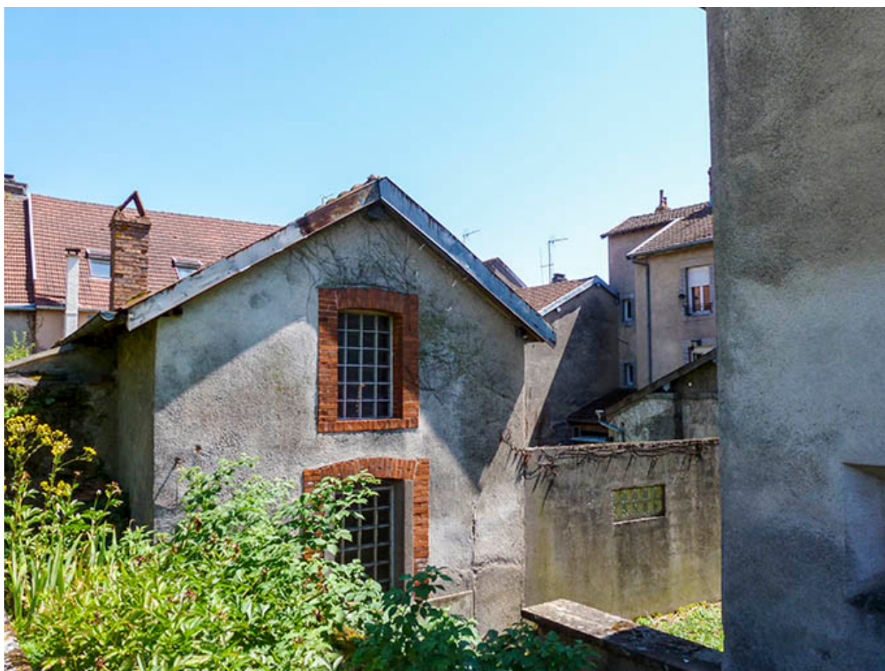
Vue générale de la remise.
