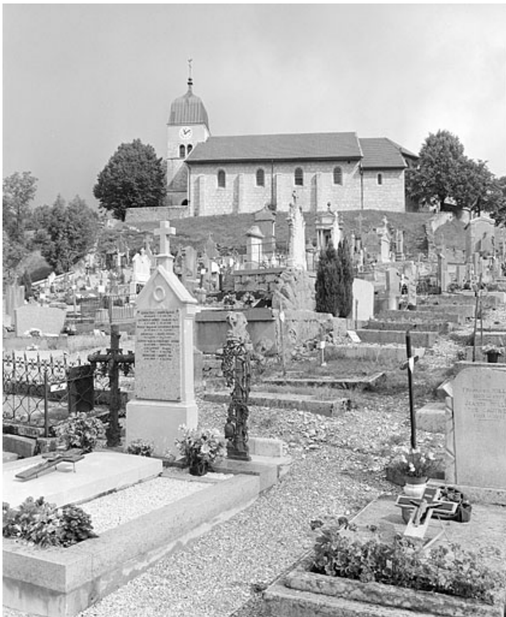
Face sud vue depuis le cimetière.
