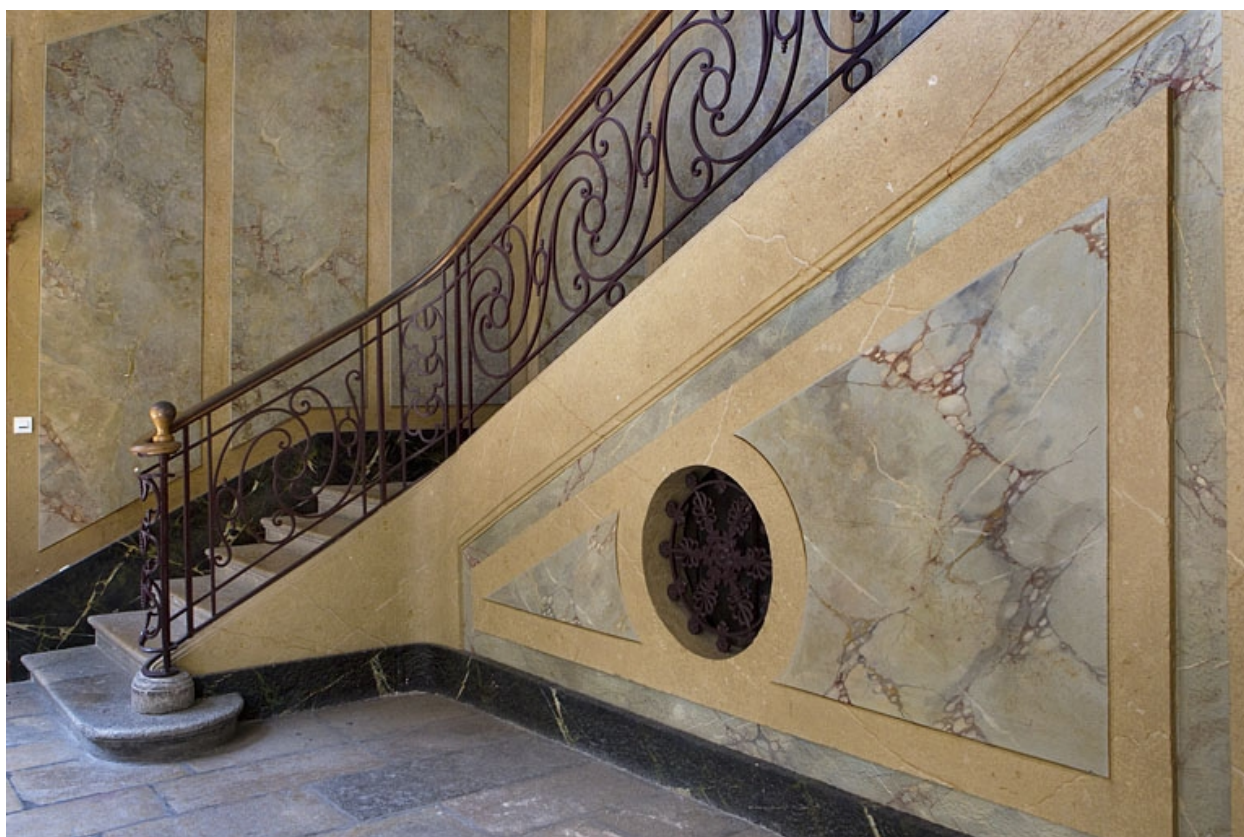
Logis principal, escalier : détail du mur d'échiffre.
