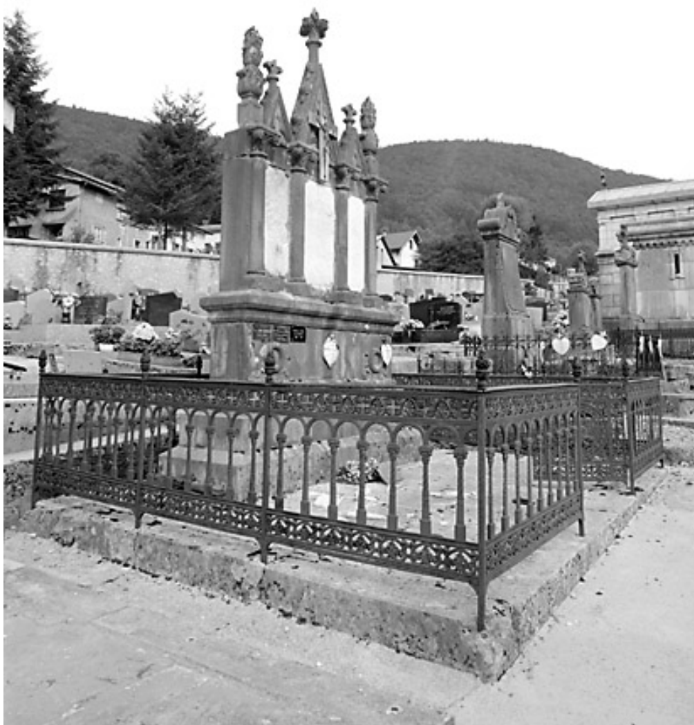
Vue d'ensemble : élévations antérieure et latérale gauche.
