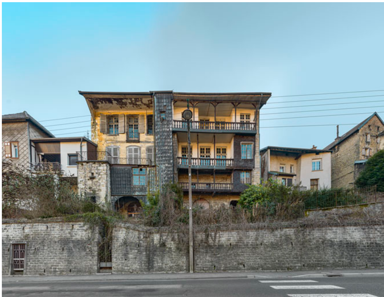
Vue d'ensemble en contre-plongée (partie droite).
