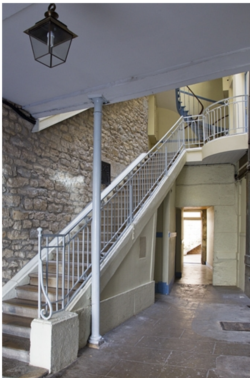
Logis principal : vue d'ensemble de l'escalier.
