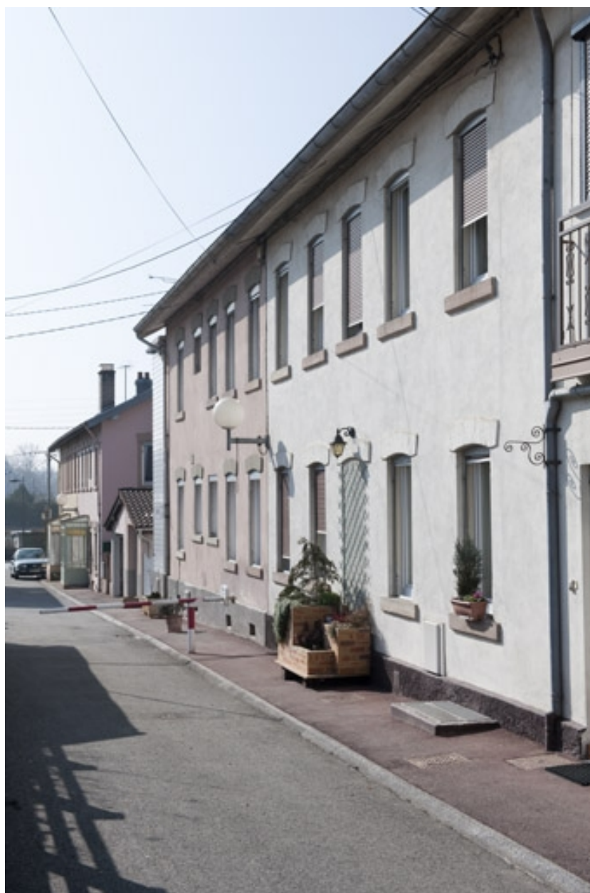
Rue des Campenottes. Habitations à 8 logements.
