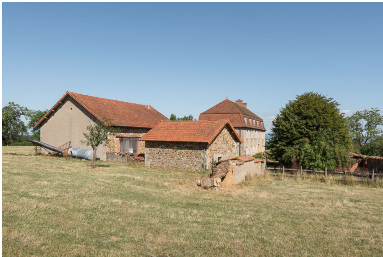
Vue d'ensemble des bâtiments du domaine
