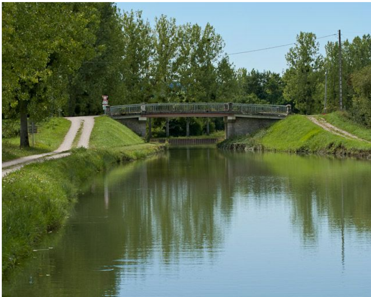
Vue du pont depuis l'amont.
