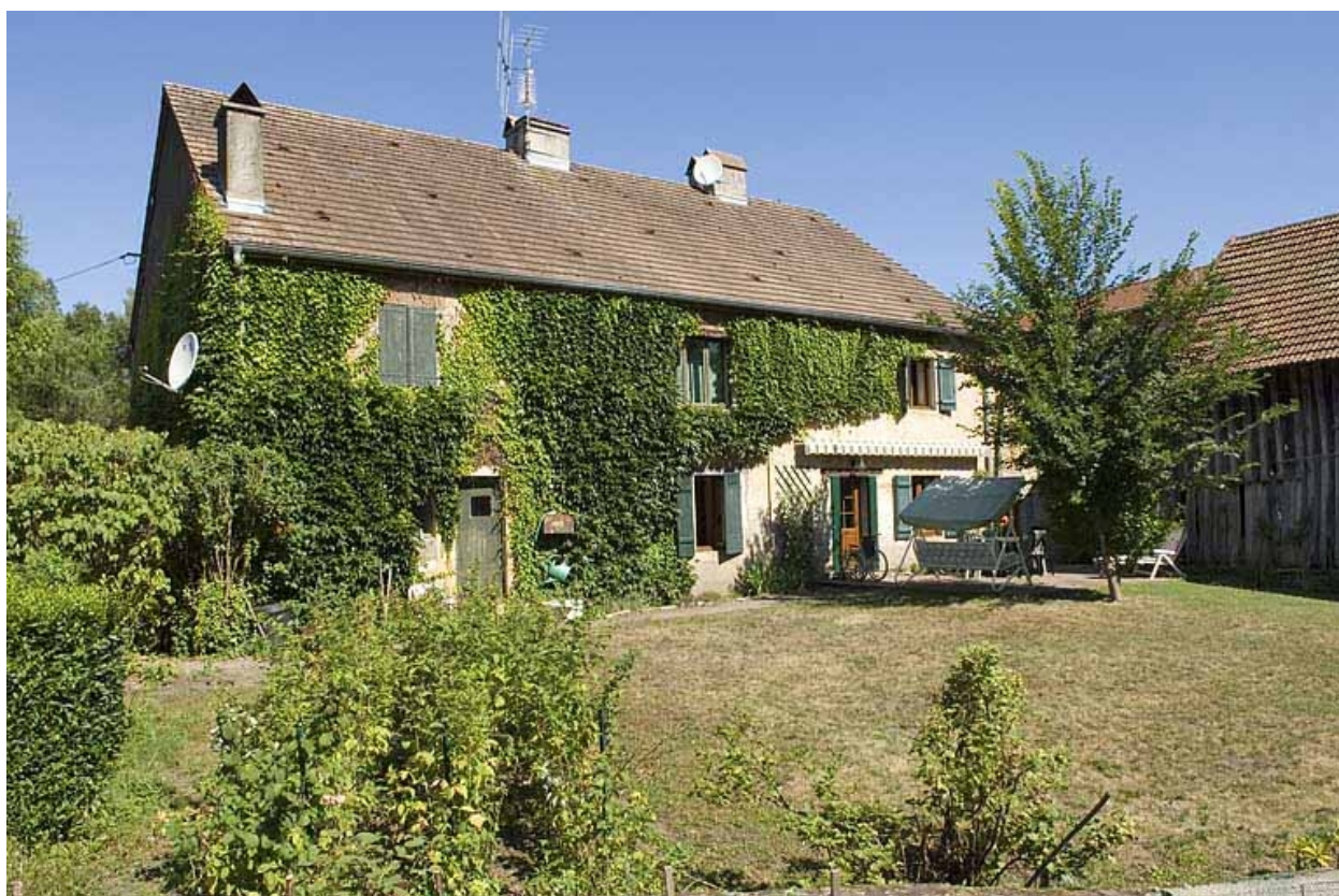
Ancien magasin, actuellement logement. Façade postérieure.
