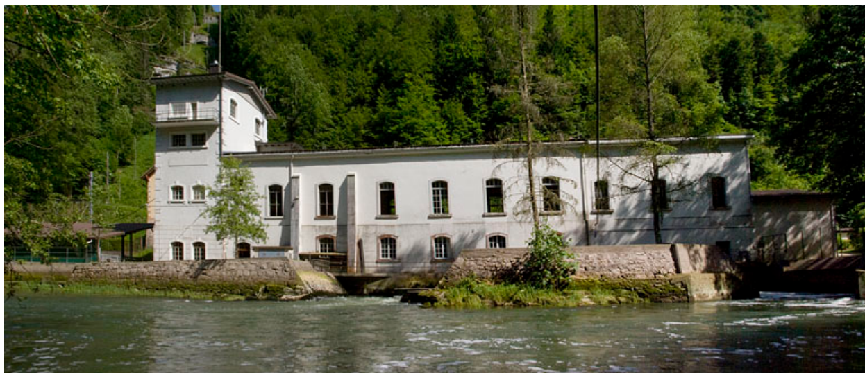
Centrale de la Goule : façade côté Doubs.
