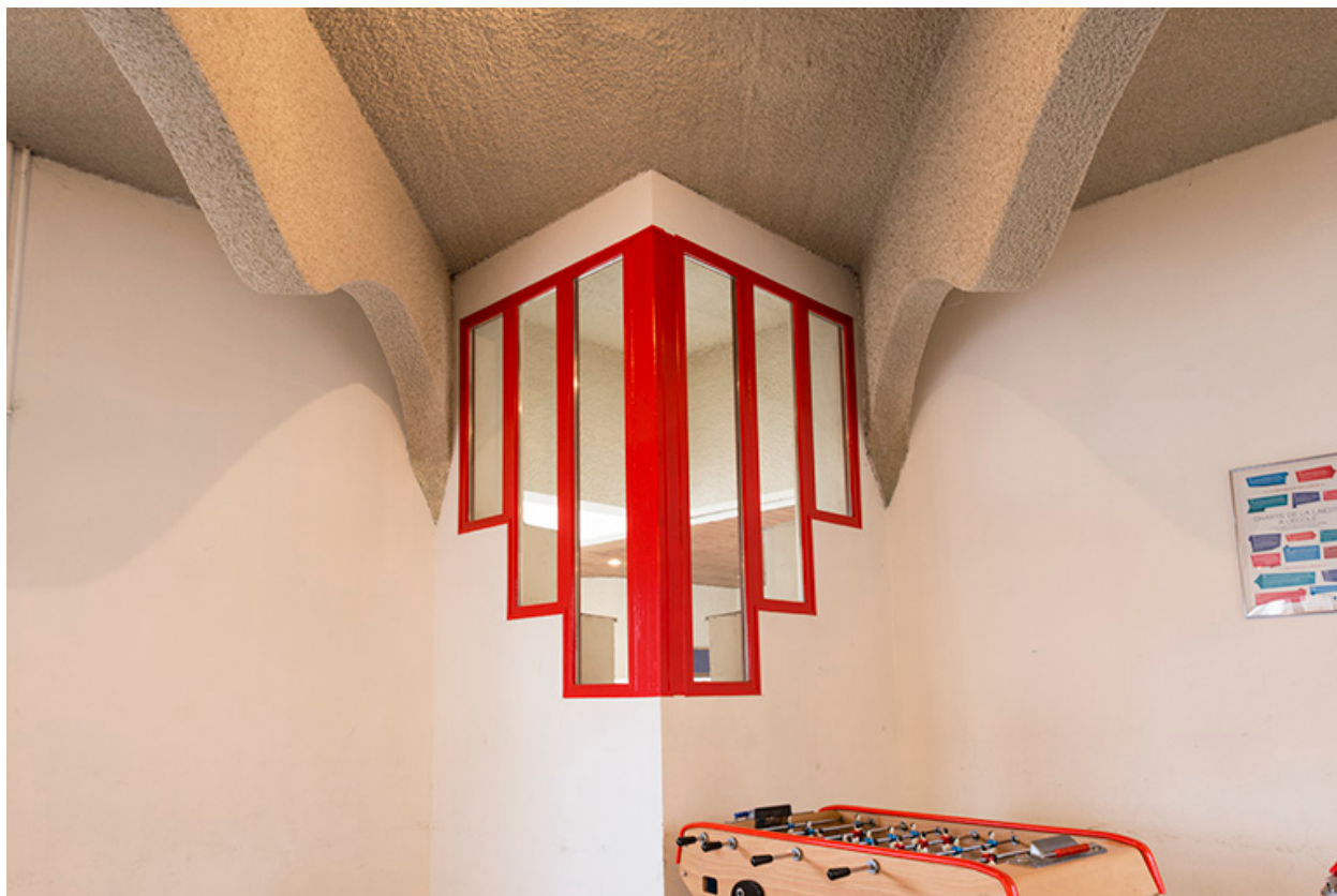
Détail de vue intérieure du foyer.
