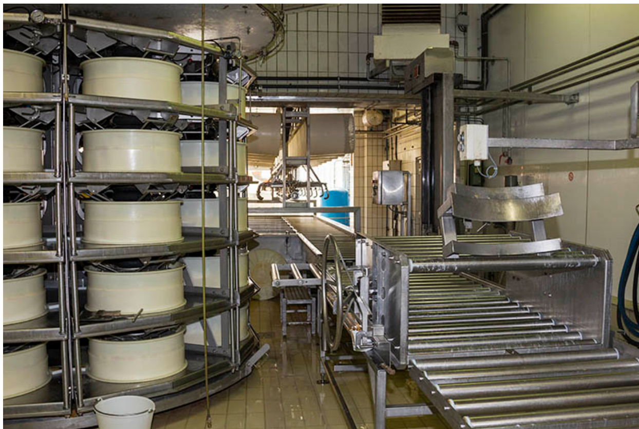
Installation de pressage et convoyeur.
