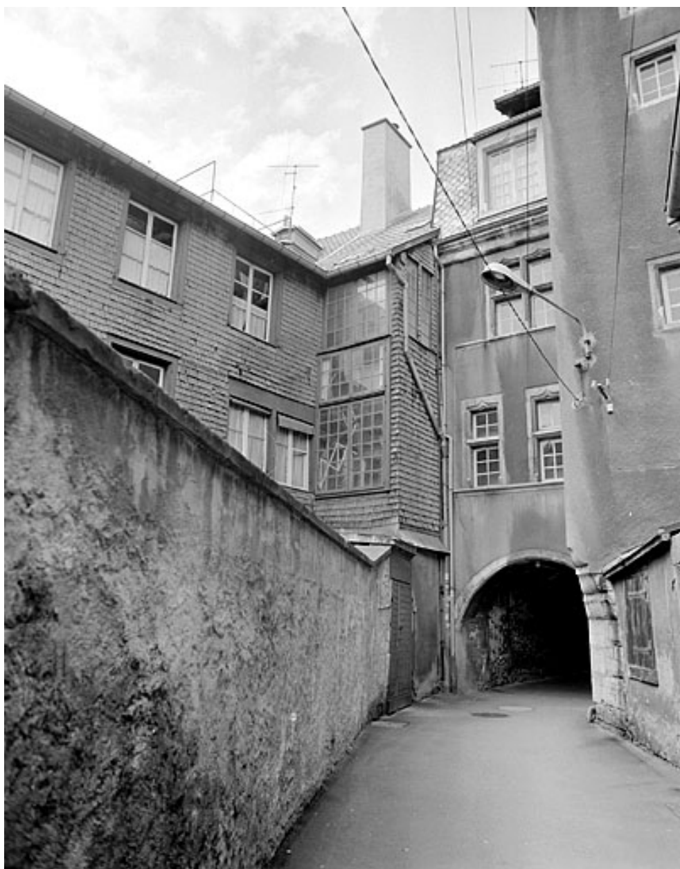
Galleries de distribution desservant l'aile en retour.
