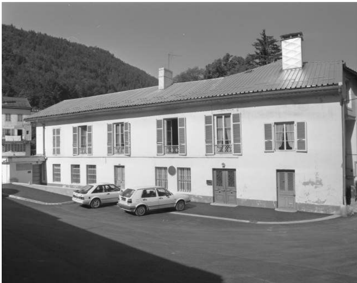
Façade antérieure du bureau et du logement.
