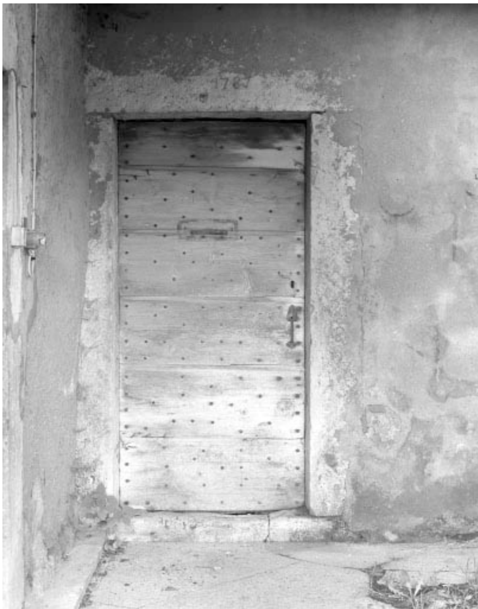
Porte d'accès au logis du rez-de-chaussée.
