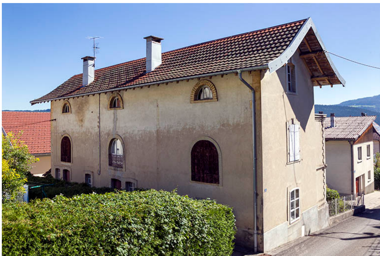
Façades postérieure et latérale gauche.
